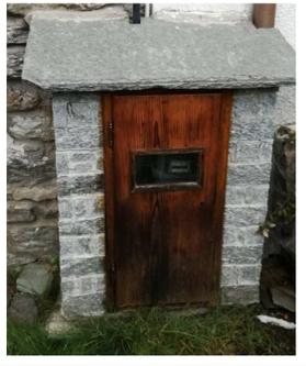
Colonnina tipo singola per alloggiamento scatole ENEL-TIM, in muratura in scapoli di cava con malta cementizia, beola da tetto spessore 2cm e serramento in legno.
