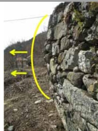
*Spanciamento nella parte superiore del muro*
