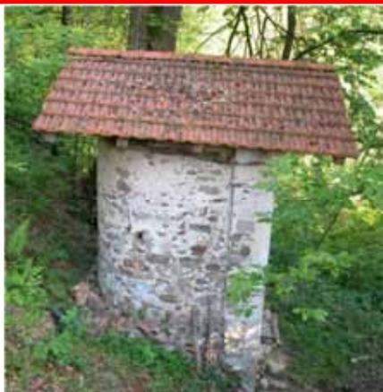
*Rifacimento di copertura con eccessivo aumento delle dimensioni dello sporto*
