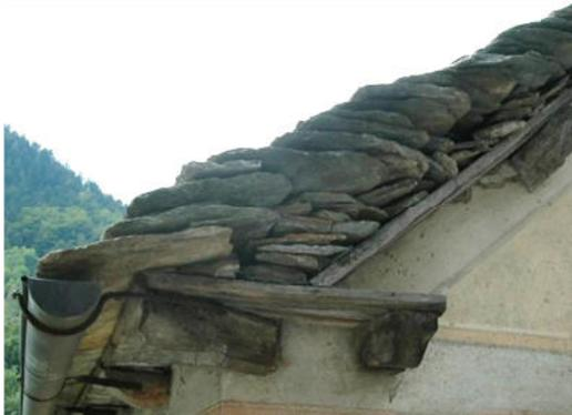
*Sormonto di 4, anche 5 piode in prossimità della gronda e riempimento con scaglie sopra al cornicione*
