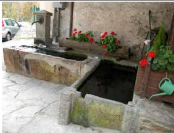
*Vasca-lavatoio realizzata con lastre di pietra assemblate mediante incastro nei pilastri angolari, collegata a fontana a bacino monolitico*
