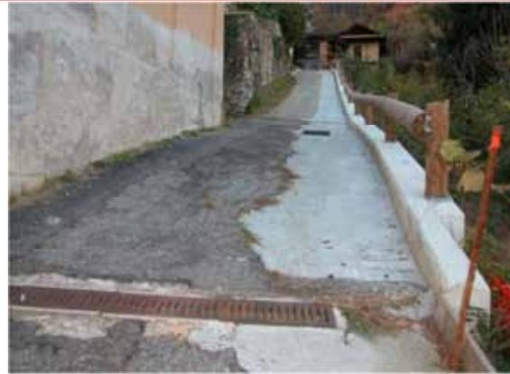
*Strada con pavimentazione in asfalto, ripristinata con malta cementizia lungo il nuovo muro in c.a. L'insieme non valorizza il contesto ambientale del luogo*
