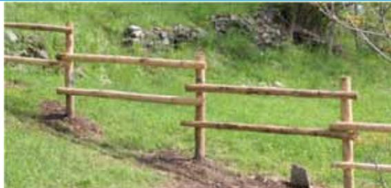
*Staccionata su pendio con elementi posati 'a scalare'. I pali sono infissi nel terreno per una profondità di circa 50 cm. Il legno utilizzato è castagno locale, scortecciato e privo di trattamenti. Sotto la recinzione si intravede un termine in pietra che indica il confine di proprietà
