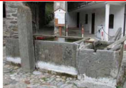
*Sigillature eccessivamente evidenti dei giunti perimetrali alla base delle due vasche; imbrattatura delle superfici circostanti; forte fuori piombo del pilastro*
