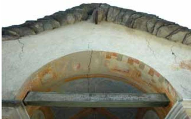
*Fessurazione in chiave dell'arco e allontanamento delle due murature di appoggio, attestata dal leggero sfilamento del trave (catena) dal muro a sinistra*
