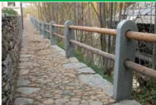
*Nuovo parapetto con montanti in pietra, di dimensioni costanti e con coste lisce, e doppia file di traverse in legno di conifera, tornito e con trattamento conservativo eseguito in stabilimento - Riva Valdobbia (sopra e dettaglio a destra)*
