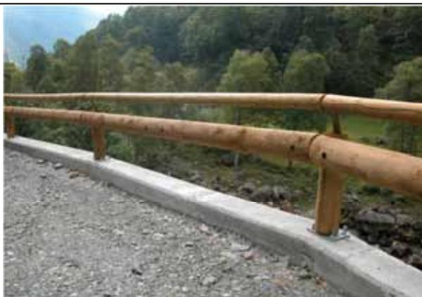
*Barriera di sicurezza con traversa e corrimano, in acciaio colore argenteo, mascherato solo sul lato frontale da elementi a mezzo legno - Fobello*
