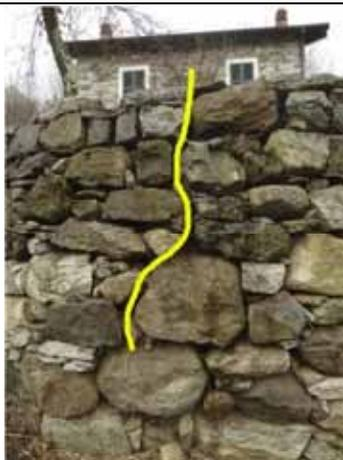
*Fessurazione: giunti verticali non sufficientemente sfalsati*
