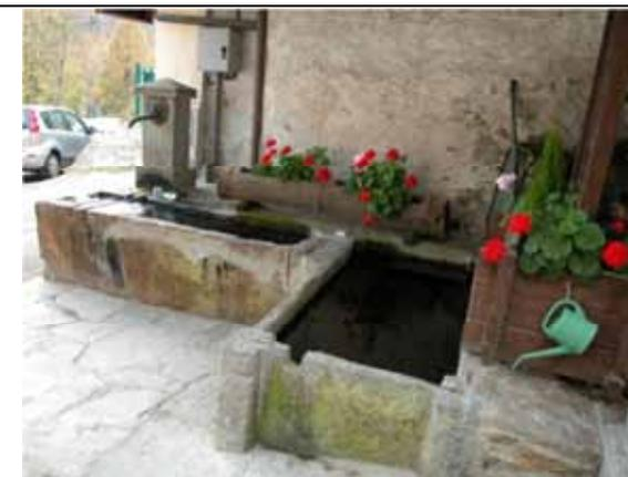
Fontana a bacino monolitico a base rettangolare, con acqua erogata tramite pilastrino, datato 1868, affiancata da lavatoio realizzato a lastre assemblate, datato 1879. Complesso coperto da tetto in piode.
