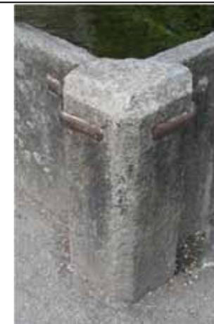
Due zanche in ferro fissate esternamente vincolano le lastre in pietra delle pareti della vasca al pilastro angolare - Scopello
