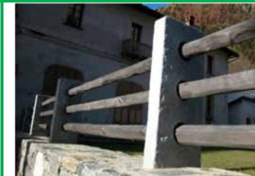
*Pilastrini in pietra con dimensione, forma e superfici regolari e precise, attraversati da triplice fila di traverse in legno trattato con impregnante scuro - Riva Valdobbia (sopra e dettaglio a sinistra)*
