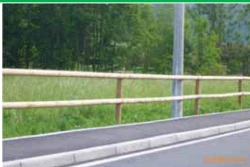
Montanti e traverse in legno di conifera a sezione circolare tornita. Le traverse, particolarmente lunghe in funzione del notevole interasse tra i pali, sono fissate esternamente ad essi
