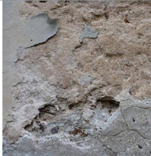
*Stratificazioni di intonaci eseguiti con diverso tipo di malta: i più profondi sono a base di calce, quello più superficiale è in malta cementizia*
