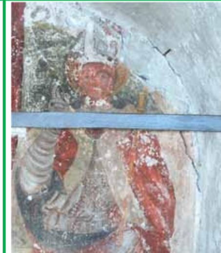
*Consolidamento statico mediante posa di nuovo tirante metallico
