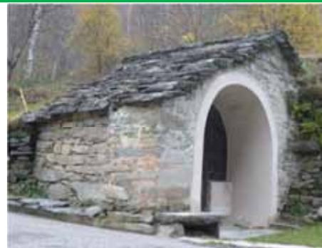
Intervento di risanamento da umidità di risalita mediante realizzazione di intercapedine ventilata lungo la base della parete laterale - Mollia
