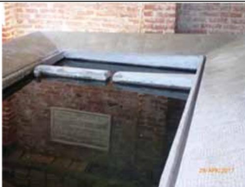
*Lavatoio realizzato interamente in cemento, in cui vengono riproposti gli elementi tipici delle vasche in pietra: scivolo con bordino di raccolta dell'acqua, setto divisorio interno – Borgosesia, fraz. Ferruta*
