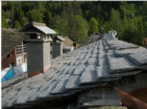
*Manto in beole di Luserna di nuova fornitura, grandi dimensioni e formato rettangolare, disposte in filari regolari con sovrapposizione di tre elementi*
