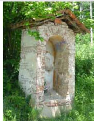
*Distacco e caduta quasi totale dell'intonaco e incipiente degrado della muratura in mattoni - Grignasco, fraz. Garodino*
