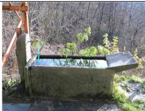
*Fissaggio di manufatto prefabbricato in cemento (scivolo) per trasformare la vecchia fontana in pietra in un lavatoio - Canepale (Sabbia)*
