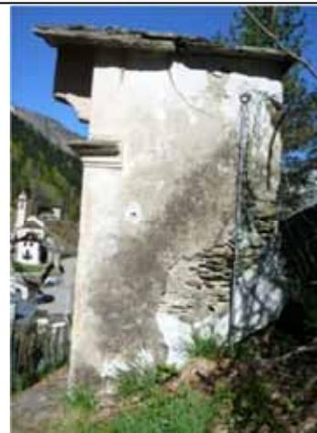
*E' visibile sul muro il livello di risalita ed evaporazione dell'acqua, con graduale degrado e patina biologica*
