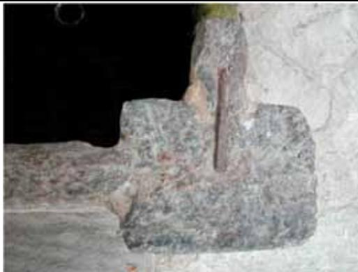
*Giunzione tra le lastre che costituiscono in fianchi della vasca, con incastro in apposite scanalature ricavate nel pilastro angolare e rinforzo metallico - Piode, fraz. Piedimeggiana*
