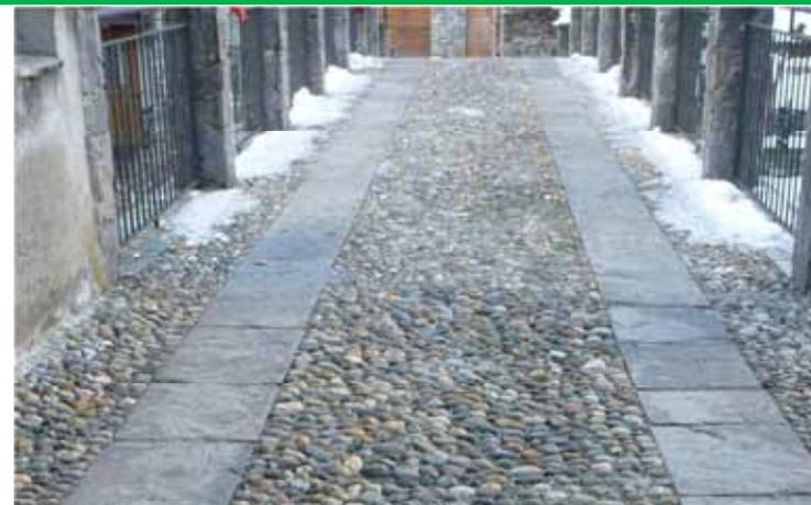
*Manutenzione straordinaria con conservazione delle vecchie pavimentazioni a ciottoli, e adeguamento alle norme di sicurezza dell'altezza dei parapetti, con aggiunta al di sopra dei muretti di barriera metallica poco invasiva visivamente. AMMESSO*
