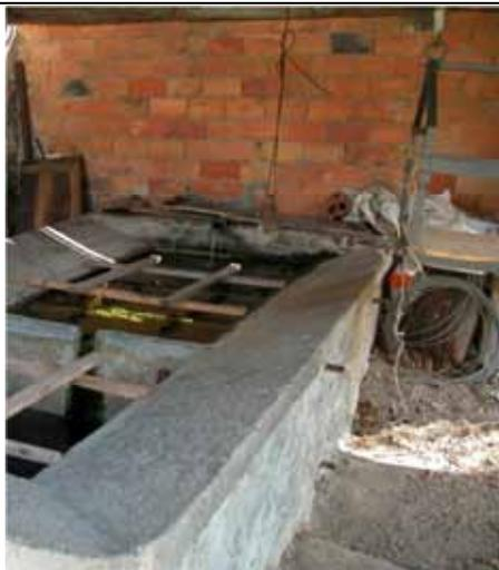
*Interventi inappropriati (nuovo tamponamento con muratura di mattoni non intonacati), degrado e impiego del locale per usi impropri*
