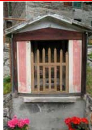
*Tetto e basamento realizzati in cemento*
