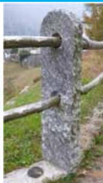
*Lavorazione rustica del piedritto, con superfici a spacco naturale e coste lavorate a martello. I fori per l'inserimento delle traverse, oggi realizzati a macchina e perfettamente circolari, nei modelli tradizionali avevano forma più rettangolare, con margini irregolari*
