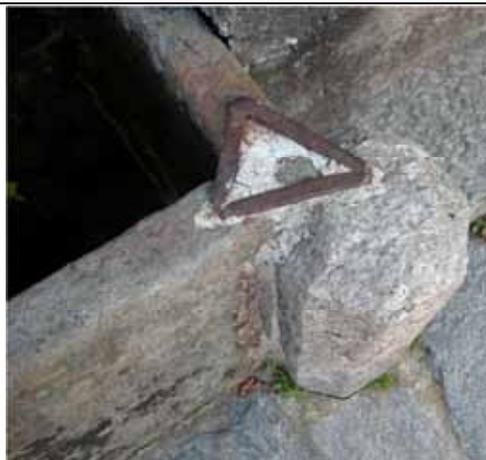
Rinforzo metallico esterno dell'incastro tra le lastre in corrispondenza del pilastro angolare - Piode
