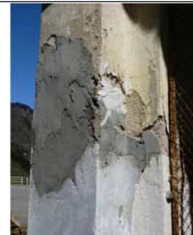
*Rappezzi d'intonaco eseguiti in maniera grossolana e con impiego di malta cementizia*
