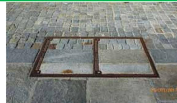
*Tentativo volonteroso di mascherare i coperchi dei pozzetti integrandoli nella pavimentazione in pietra. (Con un telaio metallico di colore grigio, il risultato sarebbe stato più efficace) - Alagna*
