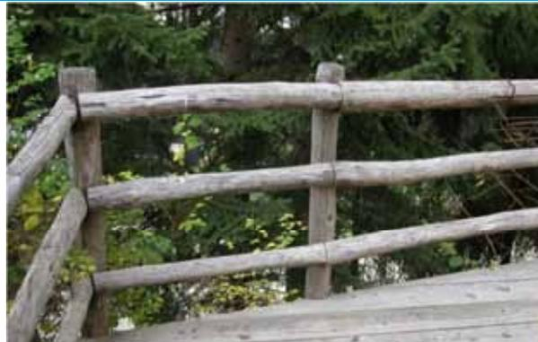
*Staccionata con funzione di parapetto anticaduta, con tre file di traverse fissate ai pali. Il legno, non trattato, presenta un aspetto gradevole dato dall'invecchiamento naturale - Riva Valdobbia*
