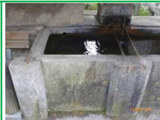
*Soluzione adottata in alcune fontane per risolvere il problema delle infiltrazioni di acqua sia dai giunti tra le lastre di pietra, sia attraverso la pietra stessa, degradata o fessurata: realizzazione di una vasca interna in cemento che garantisce la tenuta senza modificare l'aspetto esterno della fontana - Scopa*
