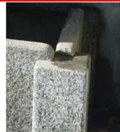
*Manufatti recenti: riproposizione della fontana in pietra a lastre assemblate mediante interposizione di pilastri angolari. Tuttavia nella tipologia tradizionale le lastre della vasca hanno altezza uguale (o, in rari casi, di poco inferiore) a quella dei pilastri angolari e sono più sottili. Negli esempi delle foto, con elementi lapidei lavorati a macchina ed eseguiti con spessori e dimensioni maggiori, non sono stati rispettati i caratteri tipici*
