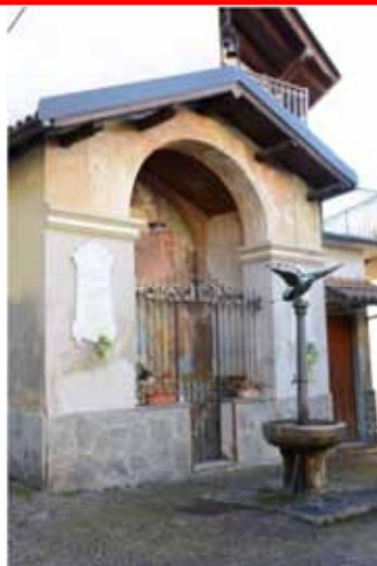
Zoccolatura di tipo inappropriato: rivestimento del muro con lastre di pietra a opus incertum
