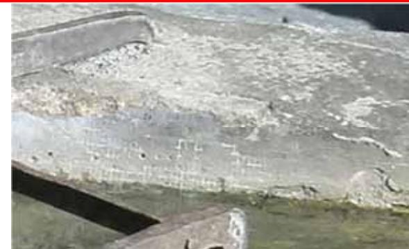
*Dalle immagini si nota però il degrado della finitura lungo la fascia di bagnasciuga, con il sollevamento e il distacco di scaglie e porzioni anche ampie del rivestimento applicato*
