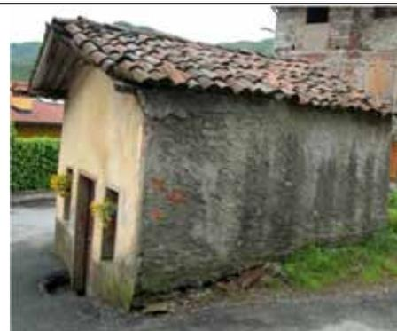
*Condizioni di degrado generalizzato, riguardante copertura in coppi, intonaci e murature, superfici interne*
