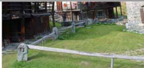
*Vecchia recinzione con rozzi piedritti in pietra locale, attraversati da una fila di traverse in legno. Alcuni pilastri, comunque di altezza contenuta, sono forniti di due fori (visibili nelle foto laterali) per soluzioni con due file sovrapposte di traverse*
