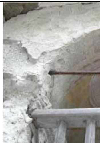
*Deposito di sali e fenomeni di disgregazione e polverizzazione della malta dell'intonaco, a base di calce spenta male, provocato da umidità*
