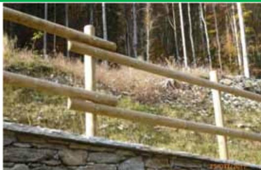
Montanti a sezione circolare e traverse a mezzo legno, fissate esternamente ai pali. Legno di conifera pre-trattato e lavorato in stabilimento; sullo sfondo: bosco di larici
