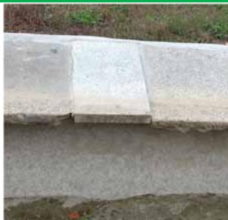
*L'intervento ha riguardato anche la lunghissima vasca a canale, provvista di lastre poste in opera inclinate (a scivolo) lungo entrambi i lati. Le lastre sostituite sono diverse sia come tipo lapideo che come lavorazione rispetto a quelle originali*
