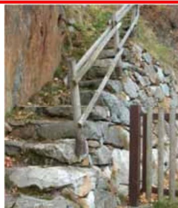
*Legname tornito e fissaggio all'esterno del muro mediante sede metallica a bicchiere. Traverse a mezzo legno*
