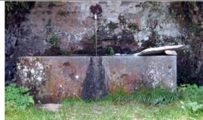
*L'ambiente umido ha favorito il degrado delle superfici lapidee, che risultano completamente coperte da incrostazioni, efflorescenze saline, impianto di muschio e licheni, depositi di ossidi – Boccioleto, fraz. Palancato*
