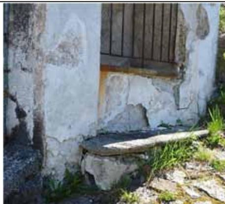
*Distacco e caduta dell'intonaco, disgregazione della malta e degrado della muratura, colature di ruggine, distacco dello scalino*
