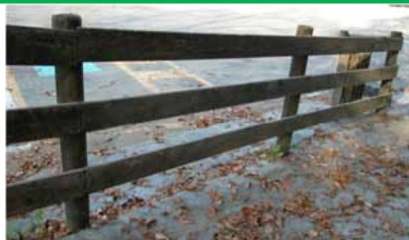
Staccionata in legno con pali a sezione circolare e traverse costituite da tavole segate e piallate, fissate esternamente ai pali, soggette a veloce degrado. Tipologia accettabile solo in area urbana
