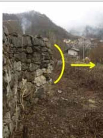
*Spanciamento della parte mediana del muro*
