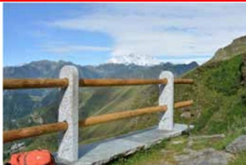
*Parapetto in un rifugio in montagna, non adatto al contesto di valore paesaggistico. Infatti è realizzato con elementi in pietra non locale (serizzo) lavorati a macchina, con superfici lisce e coste rettificate, e traverse in legno di conifera tornito e impregnato in stabilimento (sopra e dx.)*
