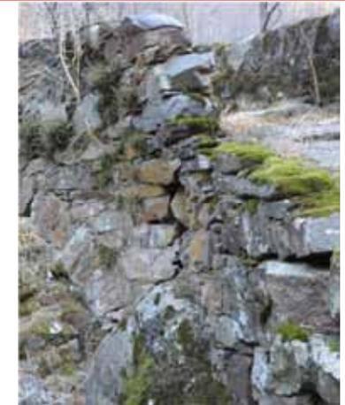
*Ponte ad arco con spalle in muratura di pietrame sconnessa e pericolante (foto a destra), ripristinata ricostruendo parte del vecchio muro con abuso di malta cementizia (foto a sinistra). NON AMMESSO*
