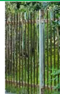
*Vicino alla barriera preesistente, in elementi di ferro a profilo aperto, con giunti imbullonati e pitturata di verde è stata posata una nuova barriera, in profili aperti e in tubolari di ferro zincato, con giunzioni saldate (già intaccate da ruggine) che si inserisce malissimo nel contesto ambientale*
