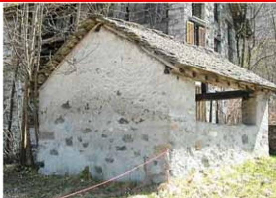
*L'impiego di malta cementizia, sia come rinforzo sulle facciate esterne, sia come intonaco applicato nella parte bassa della parete, all'interno, ha accentuato i danni causati dall'umidità di risalita nel muro in pietra, impedendone la traspirazione. Sulla muratura si vede la zona di degrado a circa 1,5-2 m da terra, corrispondente alla fascia al di sopra delle parti in cemento*
