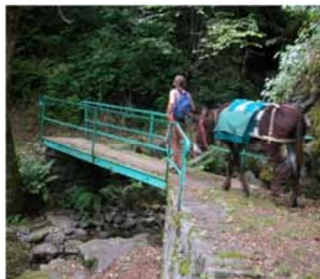
*Parapetto di ponticello, realizzato con profili pieni di ferro, con sezioni a 'C' e 'L' assemblati mediante bulloni. Costituisce una soluzione accettabile ed è ormai contestualizzato nell'ambiente e avrebbe potuto esser preso come esempio nella realizzazione del nuovo parapetto, che è stato collocato a pochi metri, illustrato nelle immagini seguenti e inaccettabile.*
