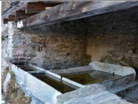
*Insolita tipologia con fontana a due vasche in linea e lavatoio perpendicolare alla seconda vasca, dalla quale viene alimentato. Manufatti costruiti con assemblaggio di grandi lastre in gneiss tabulare - Rimella, fraz. Roncaccio Superiore*
