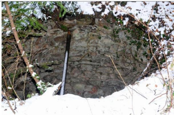
*Antico rudimentale forno da calce: vista della parete interna della struttura cilindrica in muratura di pietrame*
