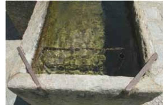
*Giunto tra lastre di pietra con taglio a 45°, con rinforzo esterno superiore mediante zanche metalliche e interno alla vasca mediante tiranti bloccati con bullone sulla faccia esterna della lastra*
