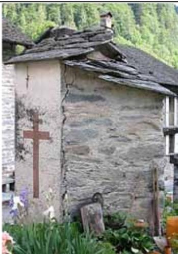
*Separazione della muratura rivelata dalla profonda fessura verticale*
