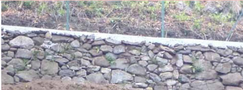
*La copertina in malta cementizia, funzionale al fissaggio di una recinzione metallica al di sopra del muro, oltre che antiestetica, snatura il concetto di muro eseguito con tecnica tradizionale a secco e introduce materiali non idonei (cemento, picchetti e rete metallica)*
