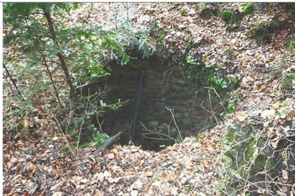
*Antico rudimentale forno da calce: vista dell' apertura superiore per l'introduzione del materiale (pietra calcarea) da sottoporre a cottura*
