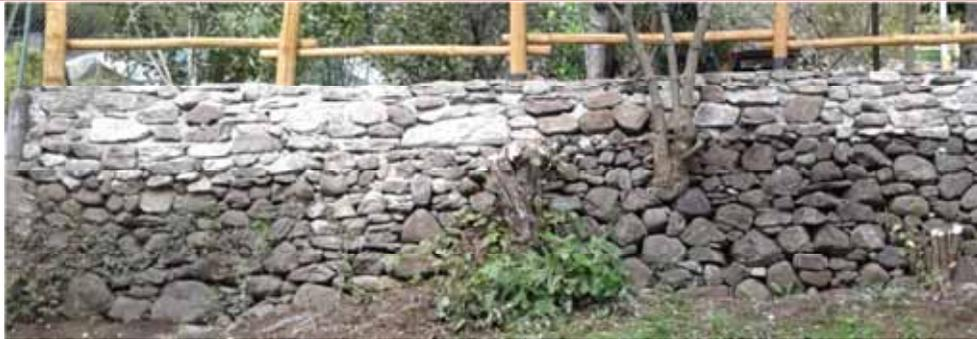
*La revisione, con ripristino delle aree sconnesse o crollate, o la sopraelevazione di un vecchio muro a secco è giusto che sia eseguita impiegando il materiale proveniente dal crollo o altro materiale di recupero, analogo a quello del muro oggetto di intervento. Ma, al fine della tutela del patrimonio rurale tradizionale, anche la tecnica esecutiva deve essere la stessa, ossia, rigorosamente a secco e non è ammesso l'impiego di malta cementizia*
