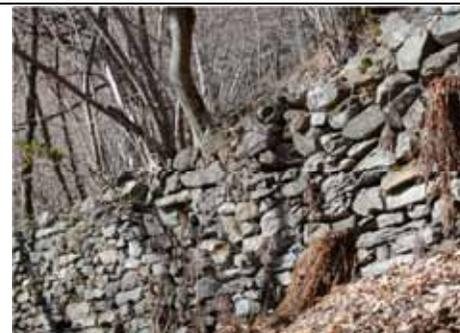
*Dislocazione e traslazione in avanti di una porzione di muro, spinto dalle radici di un albero*
