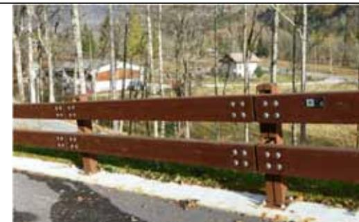
*Barriera a due fasce in acciaio corten rivestito sul lato frontale da tavole di legno; il colore della traversa metallica, visibile sul retro, è simile a quello del legno - Riva Valdobbia*
