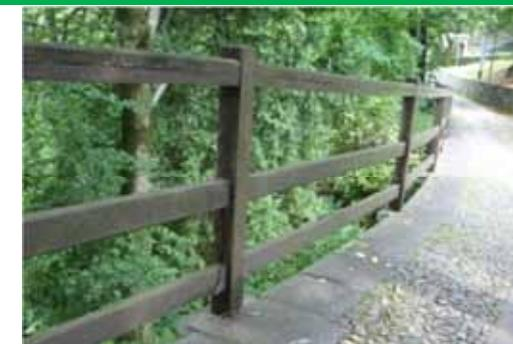
Montanti a sezione quadra e traverse in tavole rifilate e piallate, fissate ai montanti e rinforzate da mensole in metallo. La diversa altezza delle traverse non giova all'aspetto estetico del manufatto
