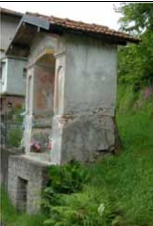
*Fascia di erosione dell'intonaco in corrispondenza della quota di evaporazione dell'umidità di risalita - Borgosesia, fraz. Foresto*
