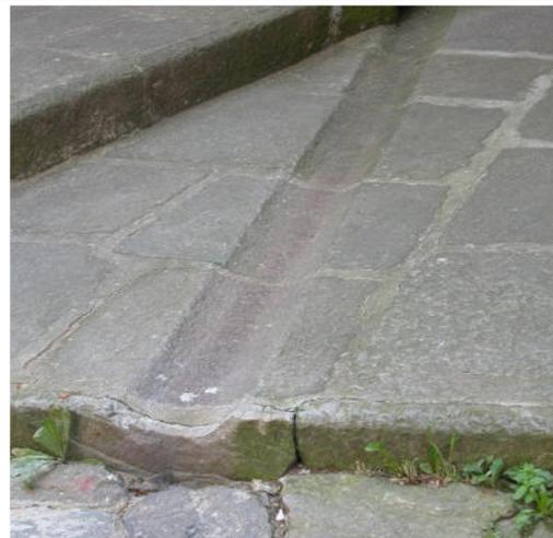
31- Mollia fraz. Grampa: pavimentazione a lastre con canaletta di scolo in gneiss massiccio
