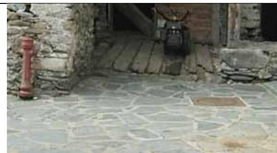
Lastricato realizzato con piccoli lastre di pietra (forse scarti di piode utilizzate per le coperture) di forma irregolare posate con ampi e molto evidenti giunti di malta cementizia
