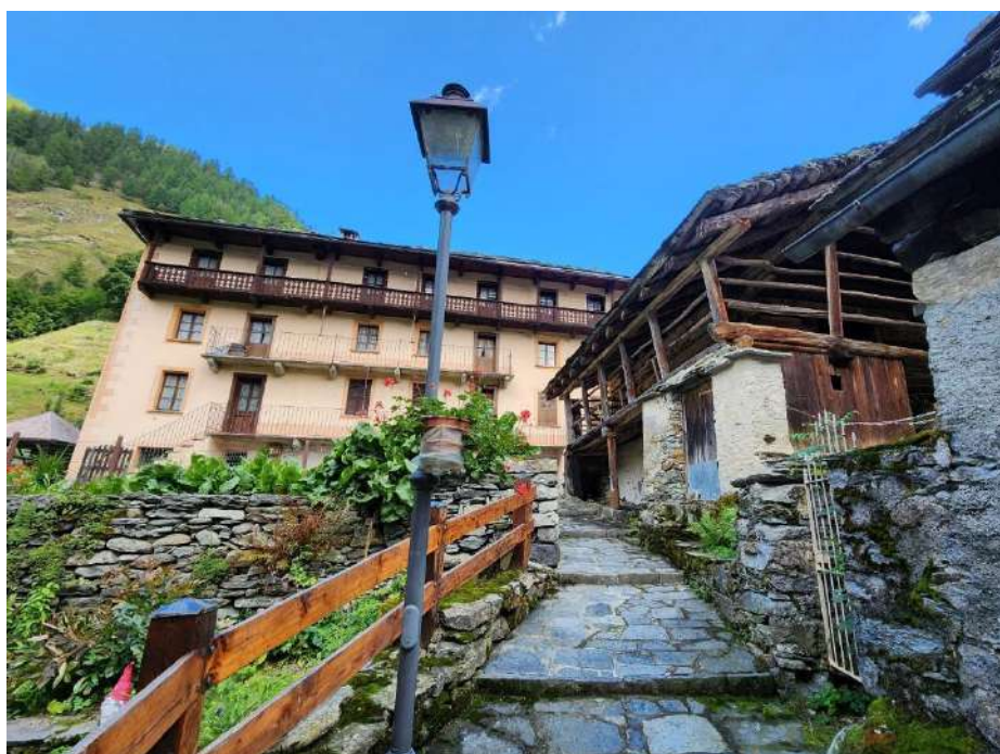
Torba con Decreto di vincolo – vista da sud
